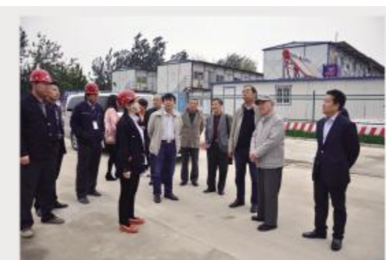
考察团在沧州市人民医院医专院区参观绿色施工工程。
